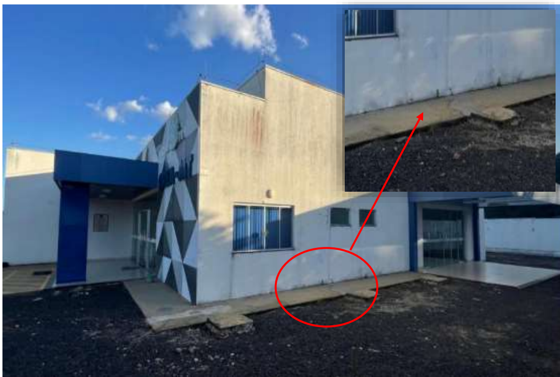
Recuperação da base da parede e pintura da área externa.
