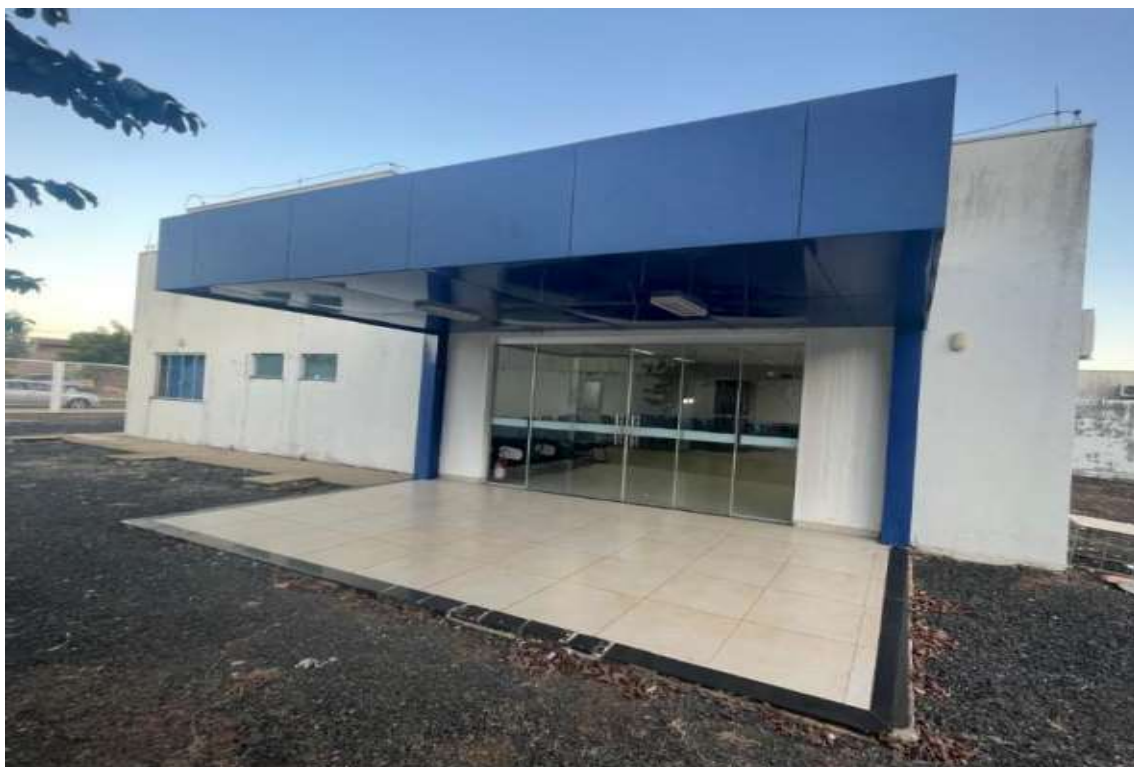
Demolição da soleira e execução de calçada de concreto.
