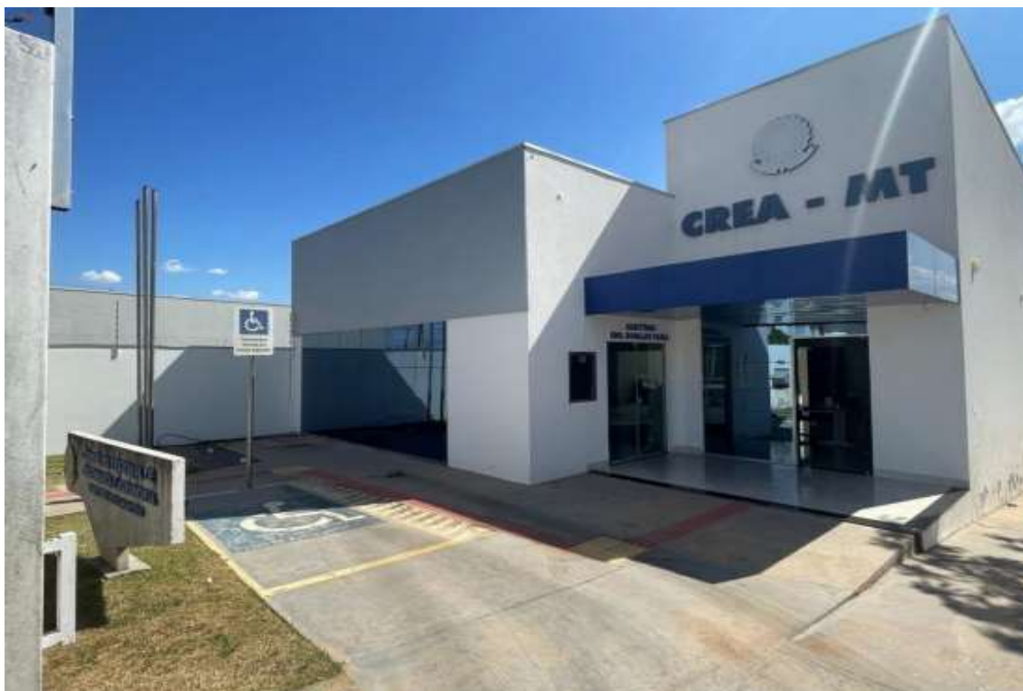
Pintura das paredes externas, pintura do ACM da fachada, letras caixa CREA- MT e substituição do brasão.
