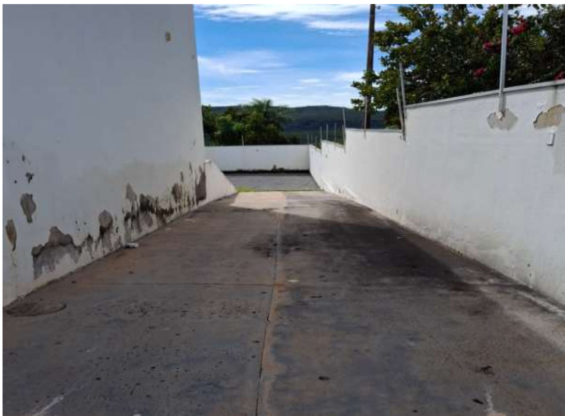
Recuperação e pintura de paredes externas, pintura da rampa, reparo rufo.
