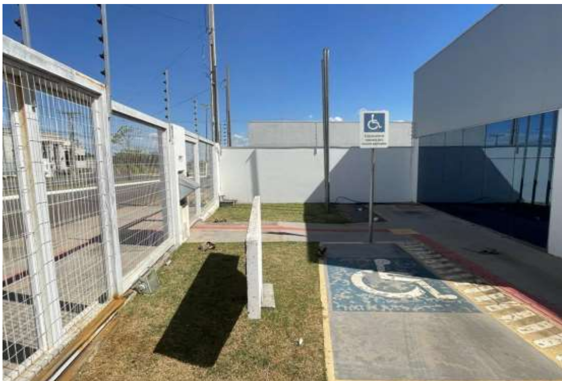
Pintura da calçada, piso tátil e vaga de PCD.
