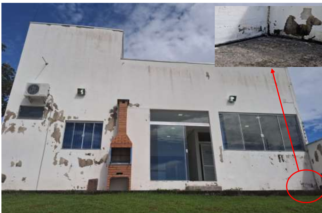
Recuperação e pintura das paredes externas e reparo calçada.
